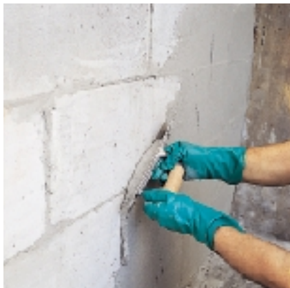
Lisciatura finale con frattazzino
